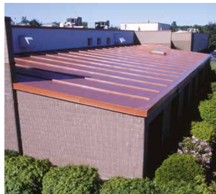
Coperture ad elevata valenza estetica
